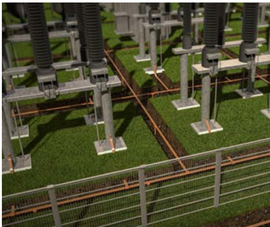
Zgrzewanie CBM Weld uziomu pomiedziowanego z bednarką pomiedziowaną
